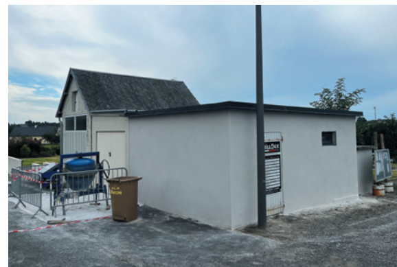
Réfection de la façade des garages
